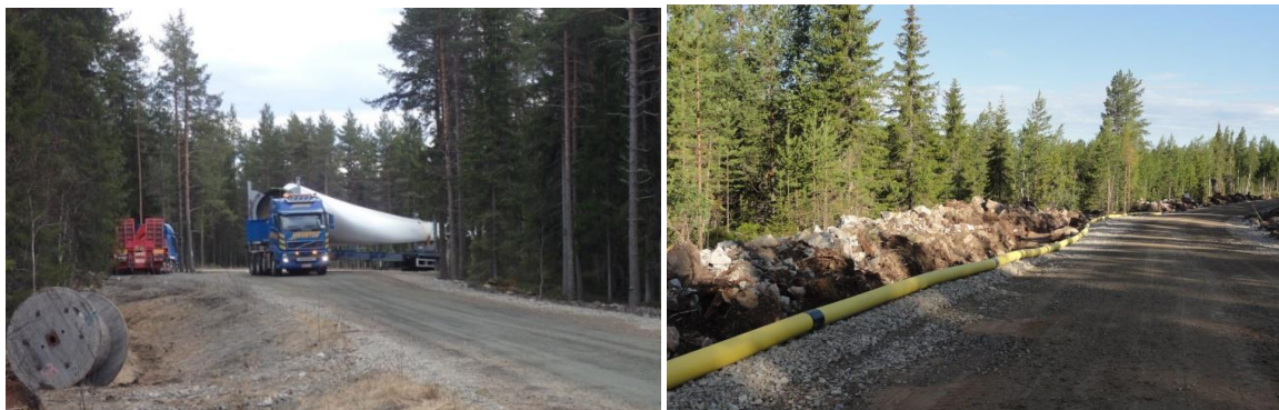
Kuva 2-13 (Vasemmalla) Esimerkki tuulivoimapuiston rakennus- ja huoltotiestä rakentamisaikana. (Oikealla) Tuulivoimalan osia kuljetetaan erikoiskuljetuksina. (Kuvat: Ville Suorsa, FCG)
