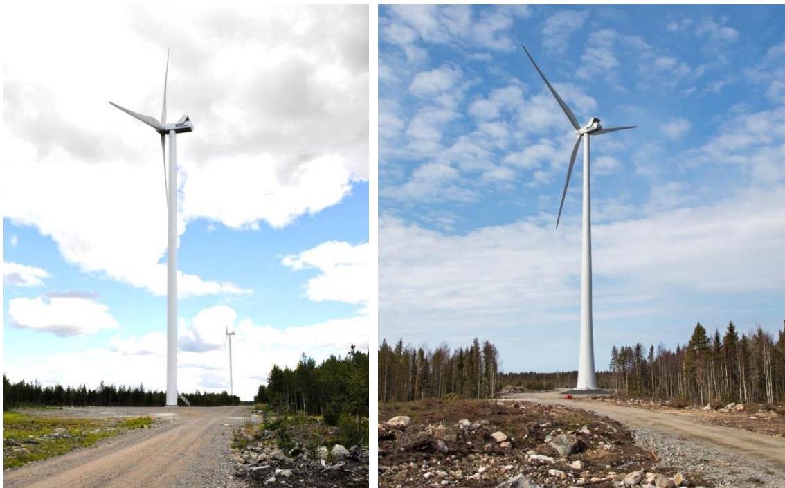
Kuva 2-8 Vasemmalla on esimerkki teräslieriötornista ja oikealla hybriditornista. (Kuvat: Leila Väyrynen ja Ville Suorsa, FCG)
