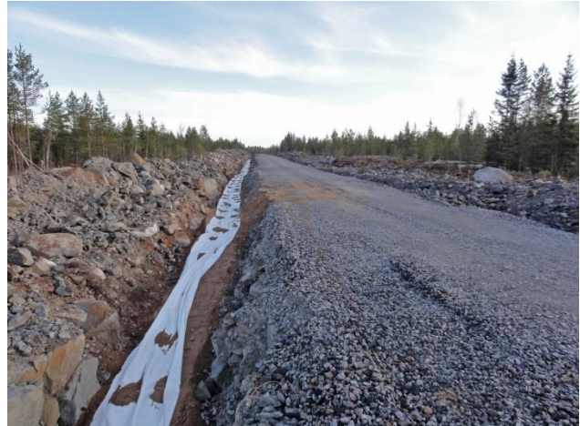
Kuvapari 2-17 Maakaapelit upotetaan huoltoteiden yhteyteen (Kuvat: Ville Suorsa, FCG).
