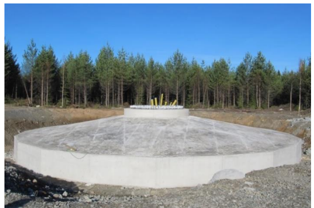
Kuvapari 2-18 Tuulivoimalan perustusten rakentamista. (Kuvat: Leila Väyrynen, FCG)
