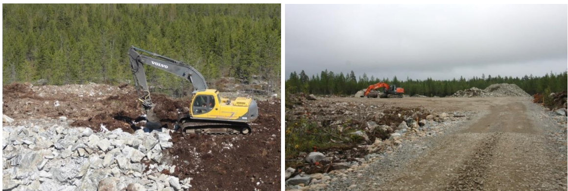
Kuvapari 2-16 Tuulivoimapuiston rakentaminen alkaa huoltoteiden ja pystytysalueiden rakentamisella (Kuvat: Ville Suorsa, FCG).
