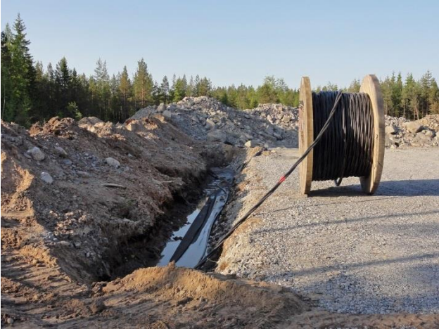
Kuvapari 2-17 Maakaapelit upotetaan huoltoteiden yhteyteen (Kuvat: Ville Suorsa, FCG).
