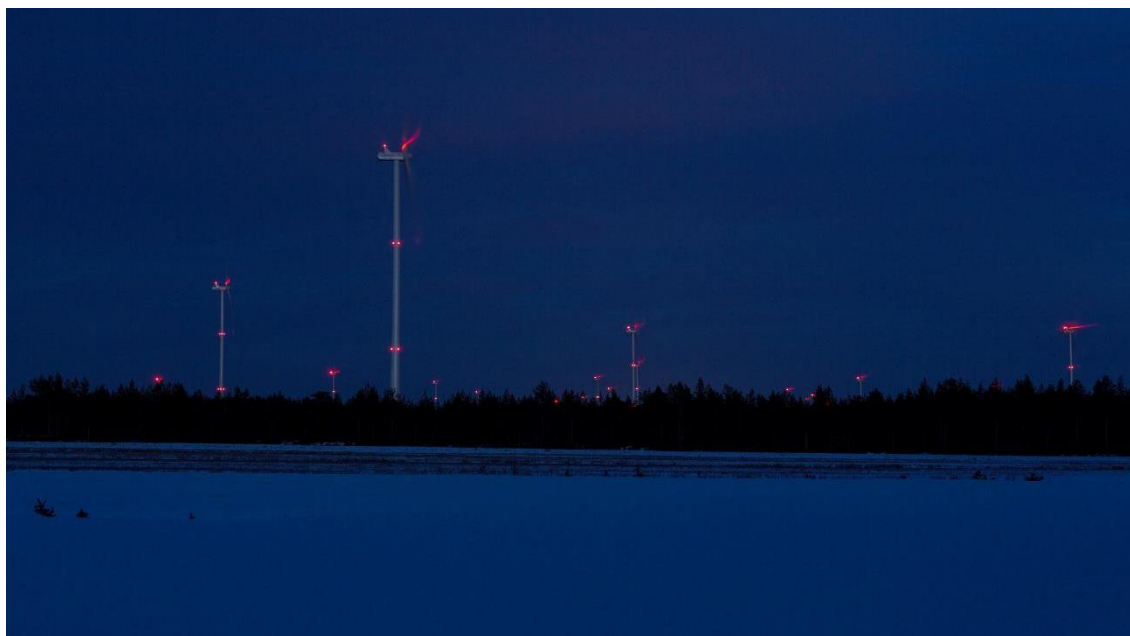
Kuva 2-11 Kiinteät punaiset lentoestevalot. (Kuva: Ville Suorsa, FCG)
