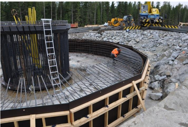
Kuvapari 2-18 Tuulivoimalan perustusten rakentamista. (Kuvat: Leila Väyrynen, FCG)
