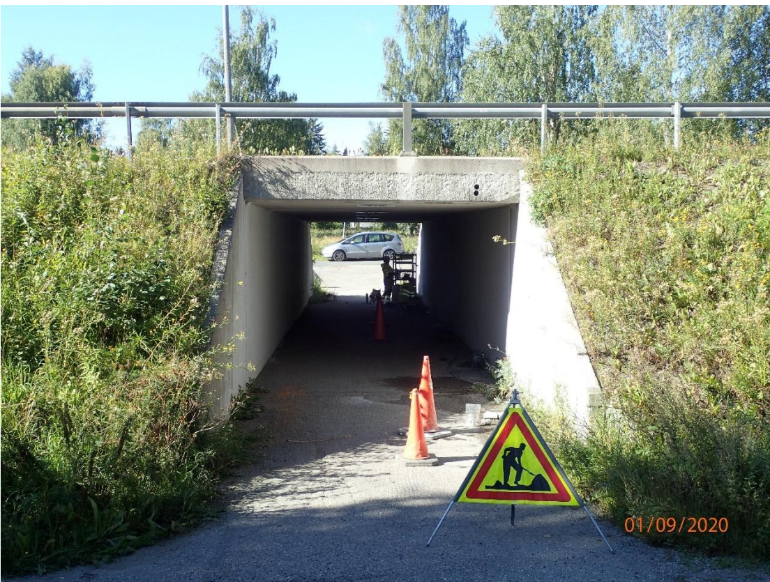
Kuva 2. Yleiskuva sillan oikealta sivulta.
