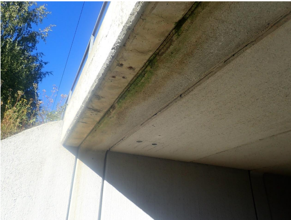
Kuva 10. Kehä- ja reunaelementin välinen sauma vuotaa molemmilla puolilla siltää
