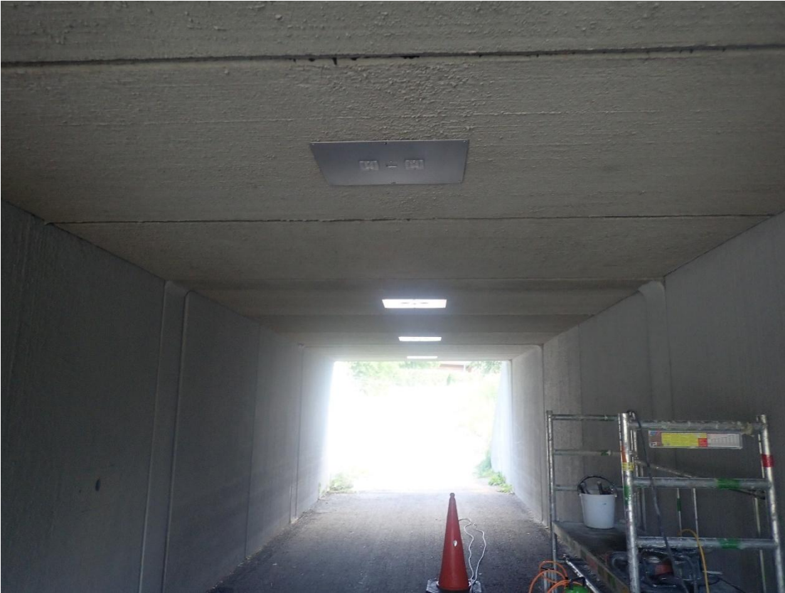
Kuva 3. Yleiskuva sillan alta.
