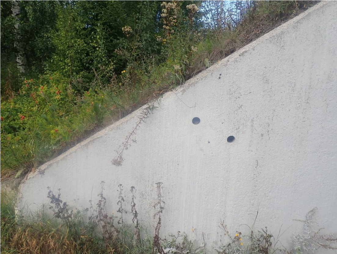
Kuva 5. Siipimuurin 2 vasen rapautumaa ja pinnoitteen hilseilyä
