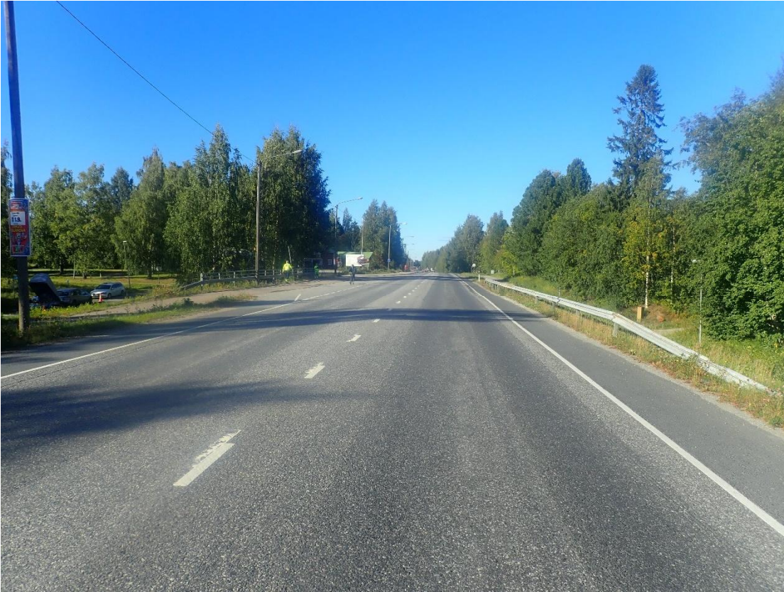
Kuva 1. Yleiskuva sillan päältä tieosoitteen kasvusuuntaan
