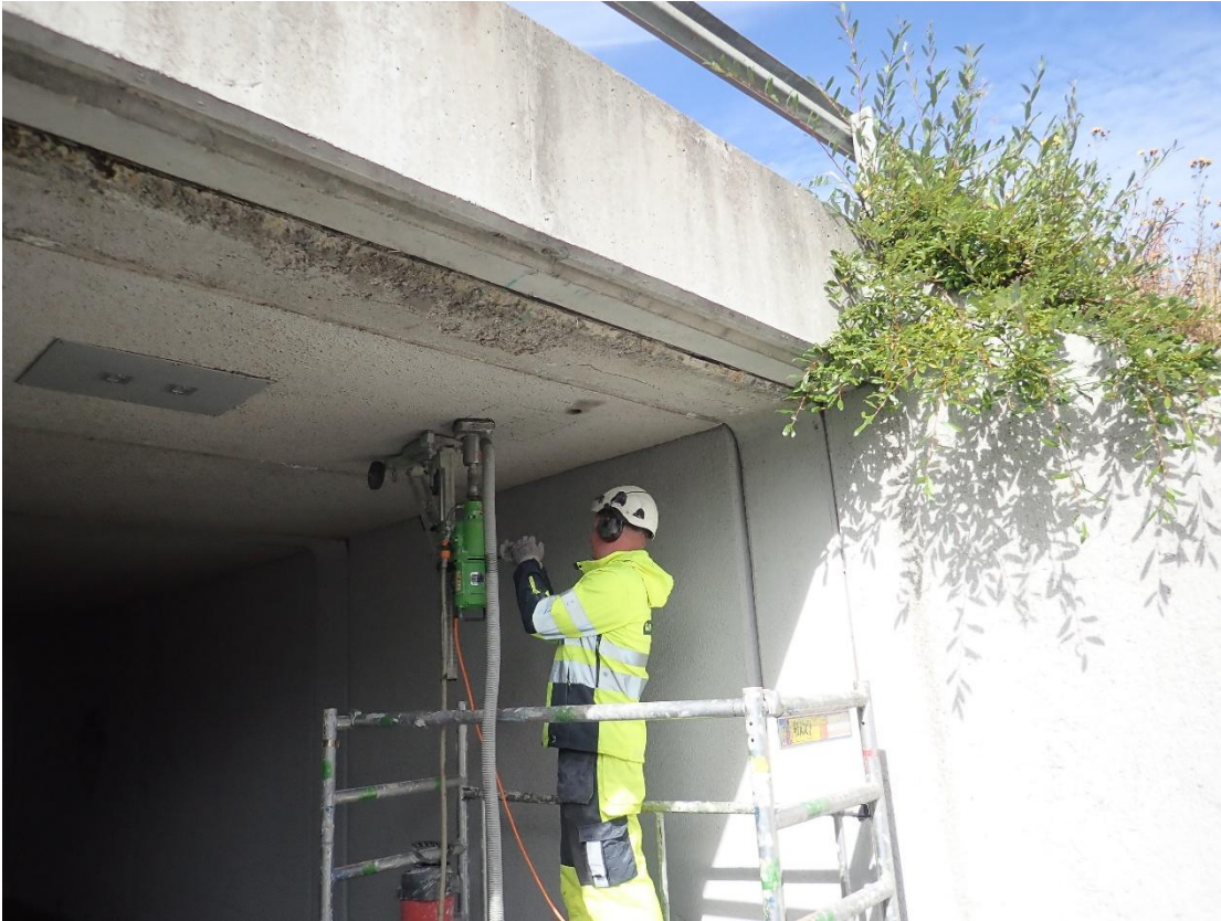
Kuva 12. Pintarakenteet tutkittiin alapäin rakenteen läpi poraamalla.
