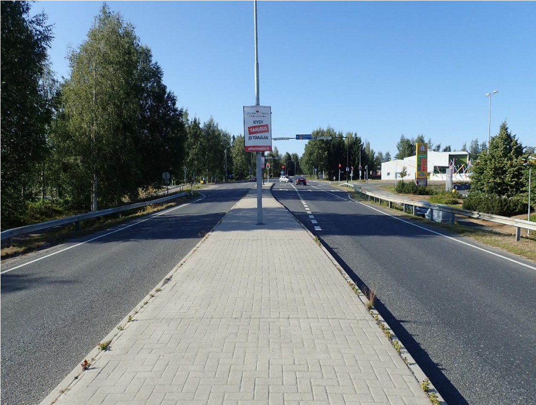
Kuva 1. Yleiskuva sillan päältä tiesoitteen kasvusuuntaan.
