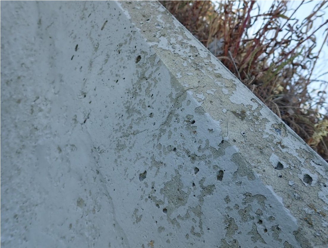
Kuva 6. Siipimuurin halkeilua.
