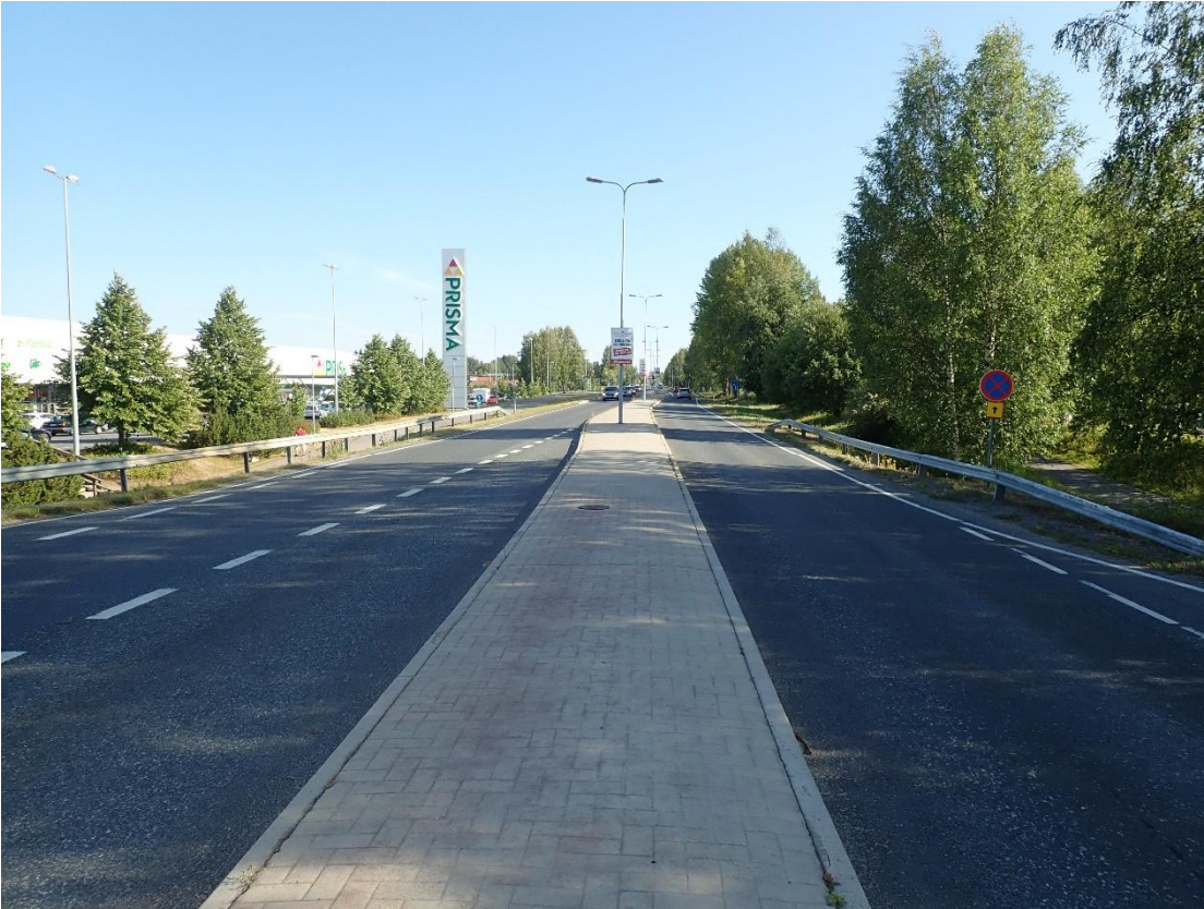
Kuva 10. Sillan päällyste on kunnossa. Ajoratojen välissä on korotettu keskisaareke, joka on betonikiviverhoiltu.
