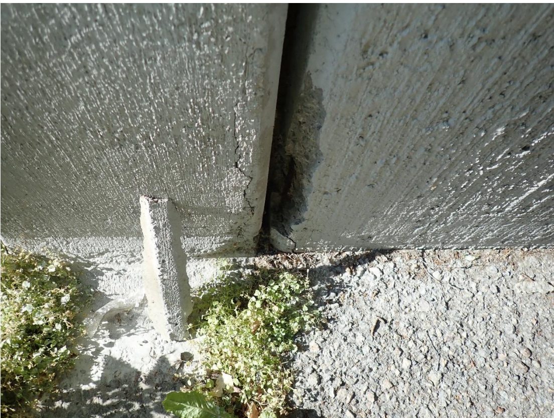
Kuva 5. Etumuurin ruostumista.
