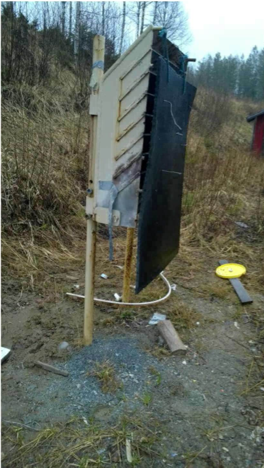
Kuva 5. Kivääriradan luotiloukku. Loukun alle varissut luotimurska tulee kerätä talteen.
