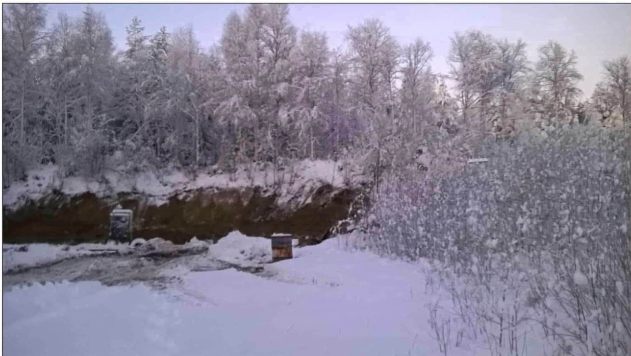
Kuva 3. Kivääriradan ampumasektorin oikea reuna kunnostustyön jälkeen.
