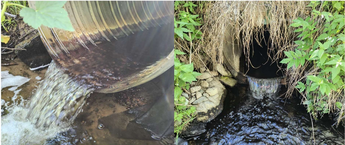
Kuvat 20 ja 21. Vasemmalla Rannantien tierumpu ja oikealla Iso-mustan alapuoleisen tien tierumpu.
