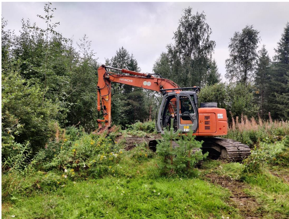
Kuva 3. Kaatopaikkapenkan luoteisosaan kaivettiin koekuoppa KK3.
