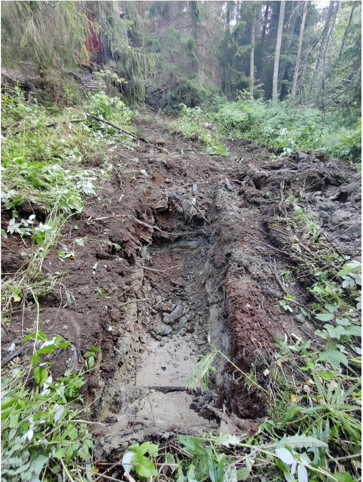
Kuva 10. Kaatopaikkapenkan länsireunaan kaivetussa koekuopassa KK15 oli jätetäyttöä pintamaassa noin puolen metrin kerros.
