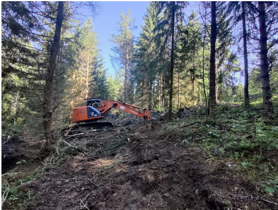
Kuva 8. Koekuoppa KK14 kaivettiin kaatopaikkapenkan länsiosaan.
