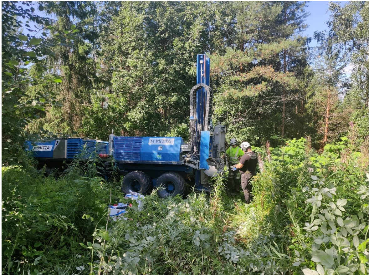
Kuva 2. Kaatopaikkapenkan päälle sijoitetussa kairaustutkimuspisteessä FCG3 todettiin noin 9 metrin paksuinen kerros jätetäyttöä.
