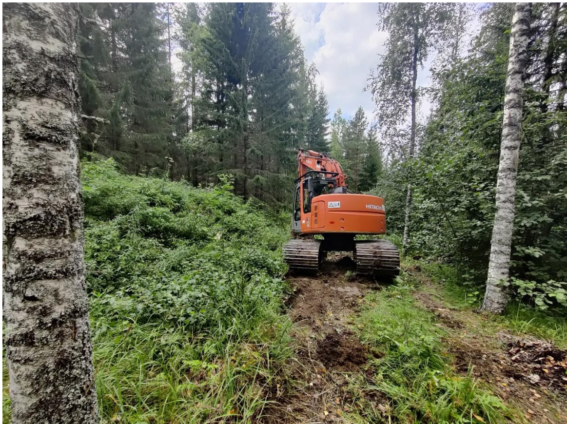
Kuva 6. Jätetäyttöä ei havaittu kaatopaikka-alueen pohjoispuolelle kaivetussa koekuopassa KK8.
