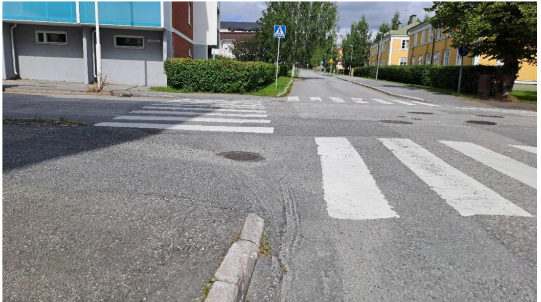
Kuva 10. Savonkadun ja Malmikadun liittymässä nousu suojatieltä jalkakäytävälle on sadevesikaivon vuoksi jyrkkä.
