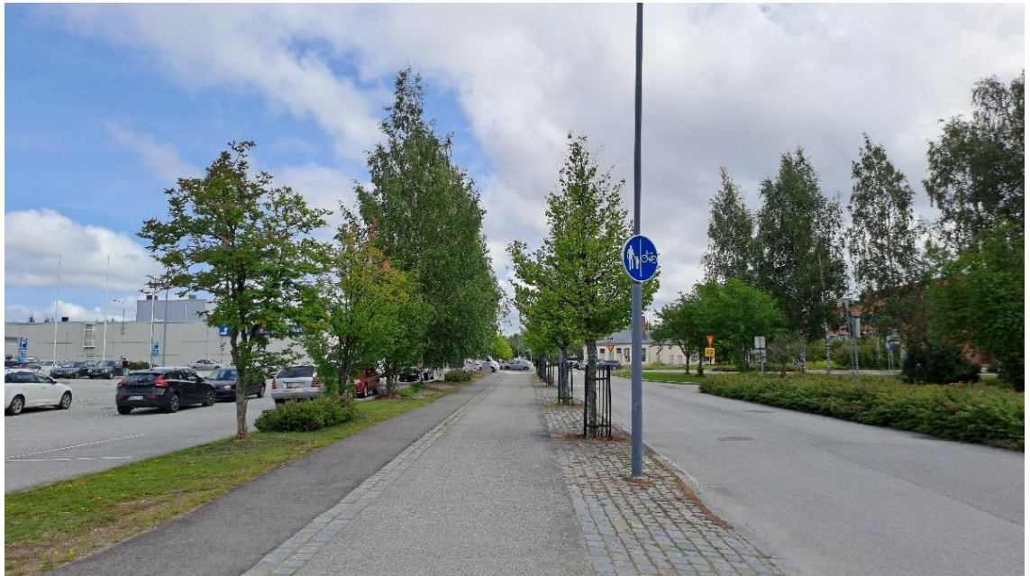
Kuva 27. Jalankulku ja pyöräliikenne tulisi erotella toisistaan erityisesti esteettömyyden erikoistason alueella, kuten tässä on tehty.
