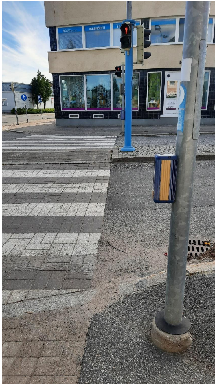
Kuva 43. Liikennevalojen painonappi saa sijaita enintään 30 cm päässä kulkuväylästä, jotta se on erilaisten liikkujien ulottuvilla. Esimerkki hyvästä sijoittelusta Kiuruvedeltä.
