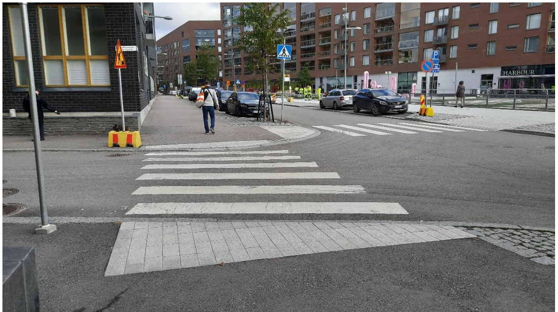
Kuva 21. Mikäli reunatukilinjaa ei ole mahdollista toteuttaa kohtisuoraan suojatien kulkusuuntaan nähden, tulisi suojatien alkuun toteuttaa oikean suunnan hahmottamista auttava varoitusalue. Varoitusalueen reuna (kuvassa etualalla) osoittaa oikean kulkusuunnan. Kuva Helsingistä.
